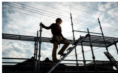
■足場工事一式 ■建方工事一式 ■特殊高所作業 ■重量物移設・設置 ■解体工事一式 ■足場資材リース
